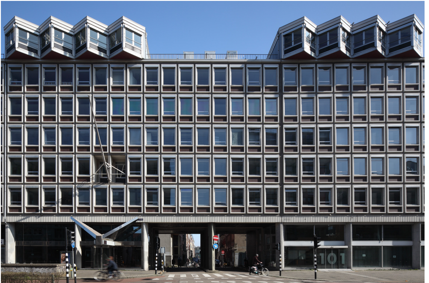
Underpass at the level of the Nieuwe Kerkstraat. Image: Bart van Hoek [2016]
